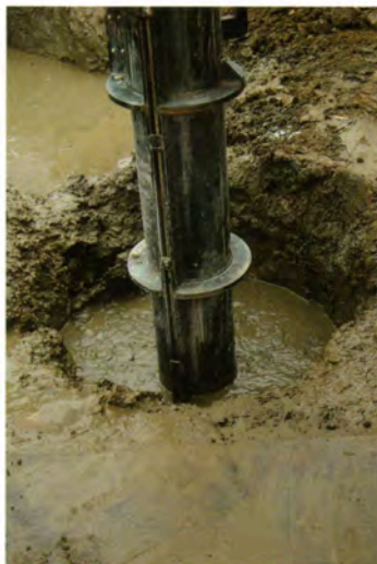
①掘削孔に装置挿入
