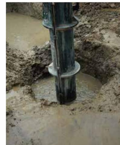
①掘削孔に装置挿入
