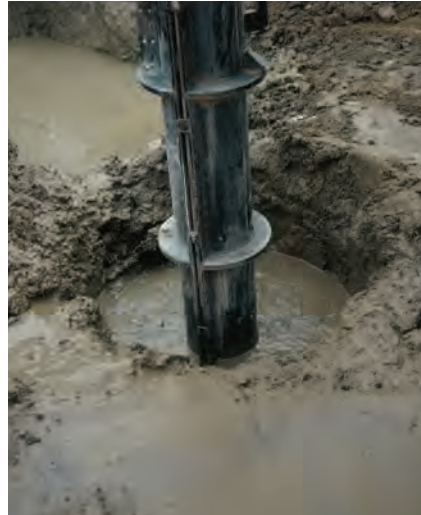
①掘削孔に装置挿入
